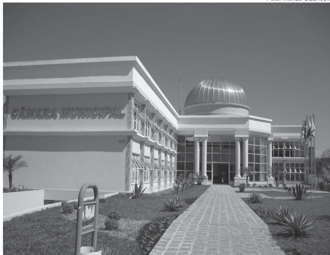
"O prédio foi construído a pouco mais de um ano e já apresenta rachaduras"
